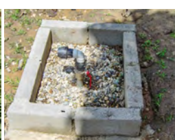
Fig. 46 Hidrante no protegido e hidrante protegido.
