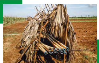
Fig. 47 Almacenamiento de las tuberías.
