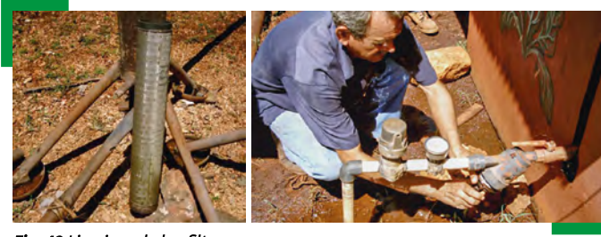
Fig. 49 Limpieza de los filtros.
