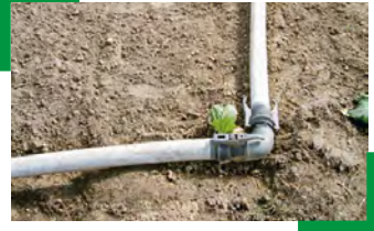
Fig. 45 Utilización del codo 90°.
