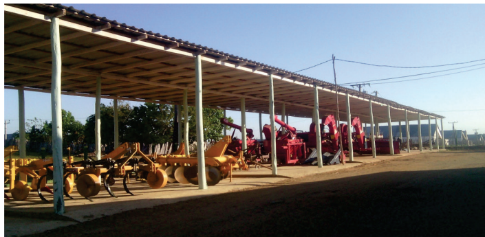
Imágenes de aulas anexas del sector tabacalero
